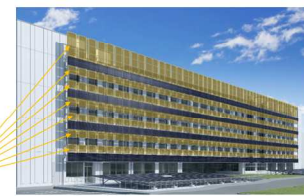
図8 シースルー型太陽光発電システム
