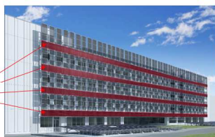
図7 単結晶型太陽光発電システム
