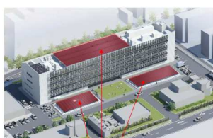
単結晶型太陽光発電設備
