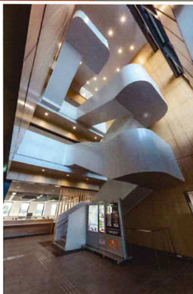
写真8 自然換気を促進する新館 エントランス階段室吹き抜け
