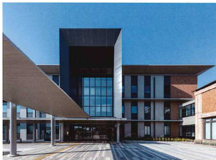
写真4 新館エントランスと大庇
