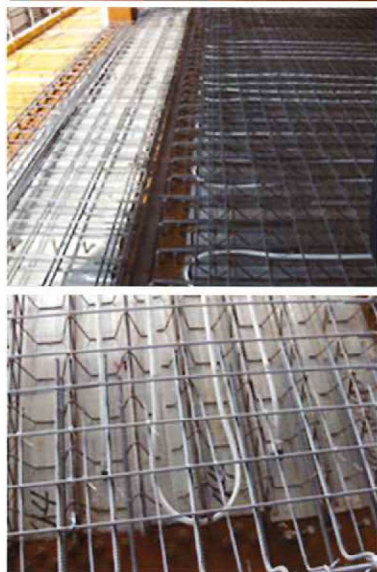
写真7 床スラブ放射冷暖房（金属強化ポリエチレン配管）施工状況：天井放射パネル（5～6万円/㎡）に比べて床スラブ放射冷暖房（5.5千円/㎡）は施工費が安価
