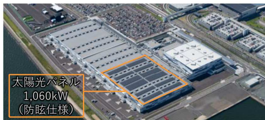
図-3 太陽光パネル設置状況
