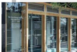
エネルギーギャラリー (設備機械室の外壁側窓面に、 設備システムの図解を描いた)
