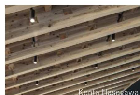
梁の透かし部分に通された照明用配管
