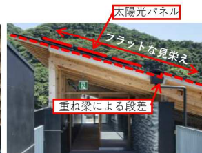
段差にパネル設置し、屋根をフラットに
