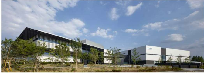
写真1 高砂熱学イノベーションセンター
