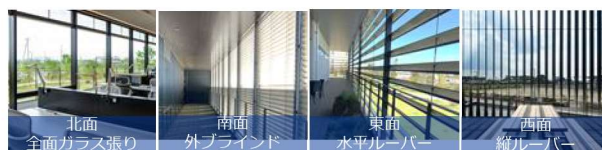
写真2 各ファサード面を室内側から見た様子
