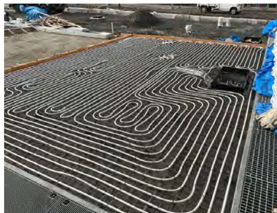
図15. 融雪配管の埋設状況
