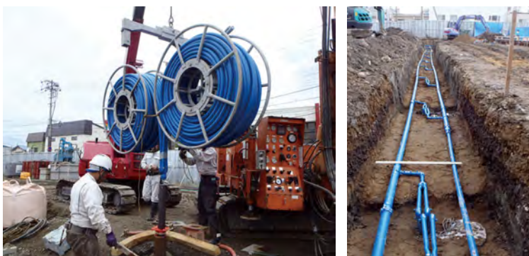
図12. 地中熱配管の設置状況
