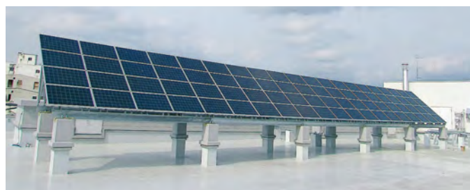
図10.多結晶シリコン太陽電池
