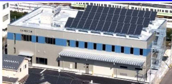
図6. 太陽光パネル設置状況
