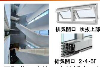
図7 曲面吹抜の自然採光・換気
