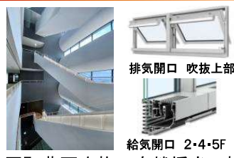
図7 曲面吹抜の自然採光・換気
