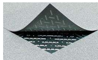
OA床とカーペットに3mmの孔があり、空気が染み出す 写真5 床空調範囲に使用している OA床とタイルカーペットの様子
