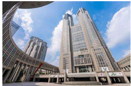
写真-1 施設外観
