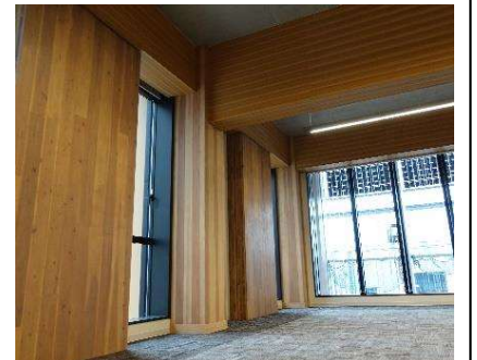
東面のCLT耐震壁
