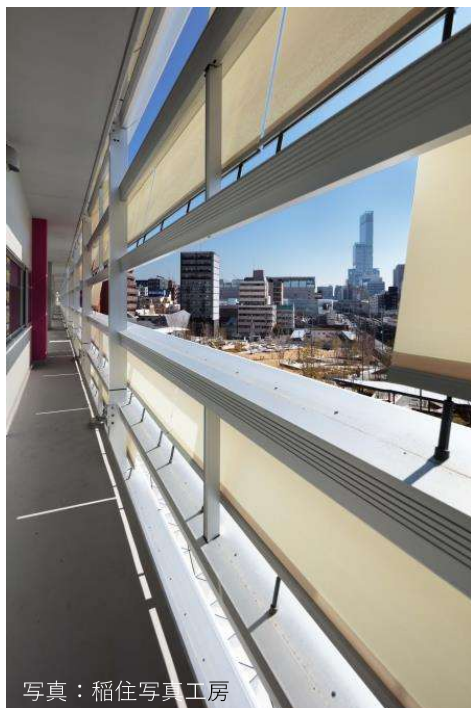
写真2 客室部分の膜外装（バルコニーより）
