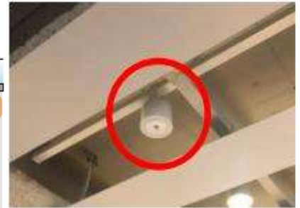
写真-3. 赤外線アレイセンサー外観
