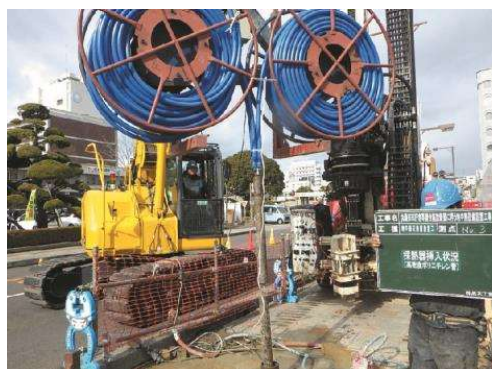
写真-7. 地中熱熱交換器設置状況
