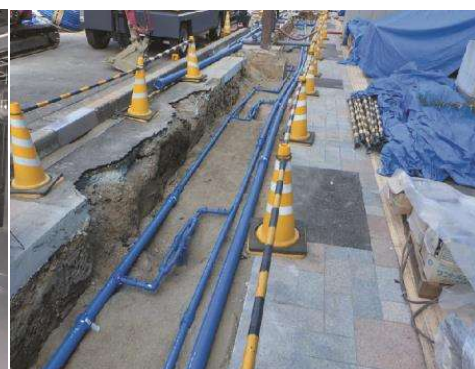
写真-9. 地中熱配管状況
