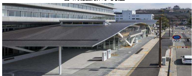
写真-6. 曲線屋根（正面外観）
