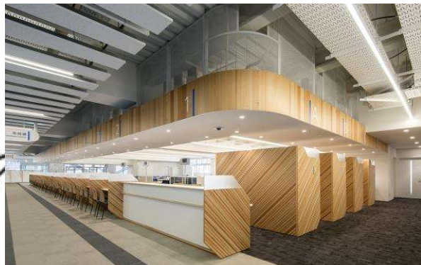
写真-11. ダクトカバーを兼用した窓口サイン
