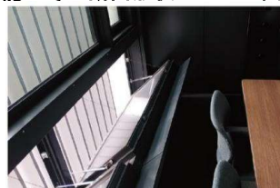
写真-6 自然換気給気口 (左) と排気口
