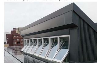
写真-6 自然換気給気口 (左) と排気口
