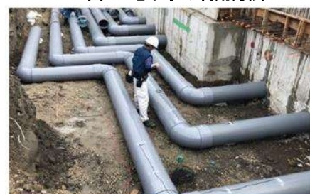
写真-7 アースチューブ敷設状況
