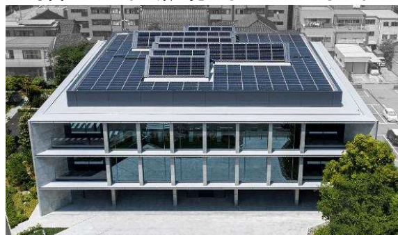
写真-3 屋上に設置した太陽光発電パネル
