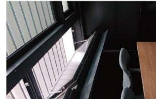
写真-6 自然換気給気口(左)と排気口
