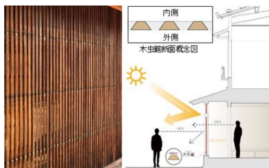
図-2 町家の木虫籠とその断面形状
