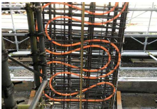
写真5 壁柱埋設配管敷設
