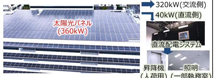
図-10 太陽光パネルと直流配電システム
