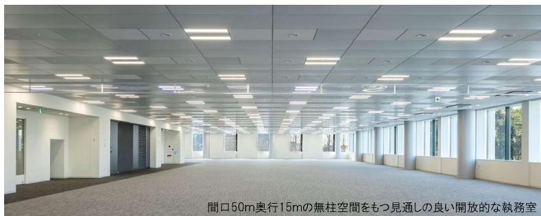
間口50m奥行15mの無柱空間をもつ見通しの良い開放的な執務室
