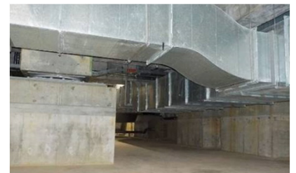
図3.5 アースチューブ設置状況写真
