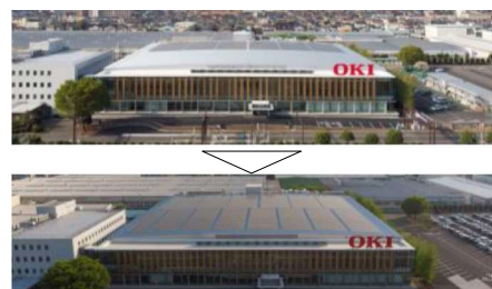
図18 太陽光パネル増設時の外観写真
