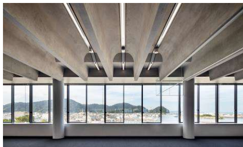
写真-12. 天井レスな執務室
