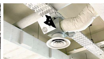
ダクト分岐とラックにより自由な機器設置が可能
