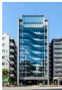
建物外観（北側）
