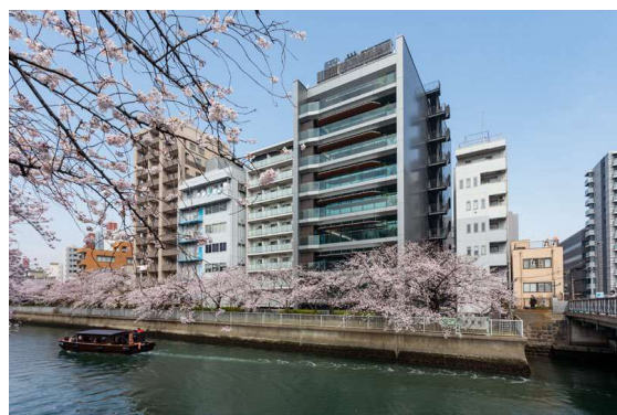
建物外観（南側）
