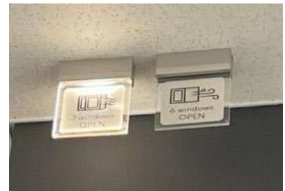
図6 自然換気窓開閉サイン
