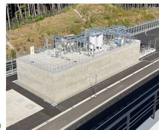
図11 地上式の浄化槽
