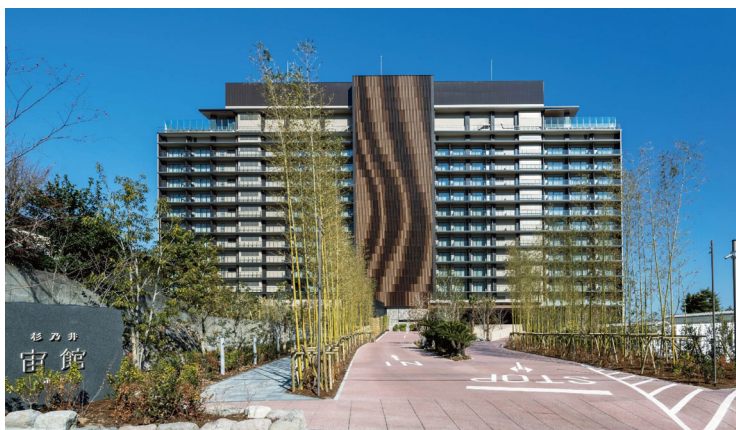
写真-1 建物外観
