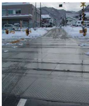
写真11 踏切融雪の状況
