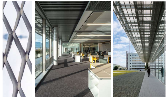
エキスパンドメタル 執務室に取り込む日射を制御 庇下の空間
