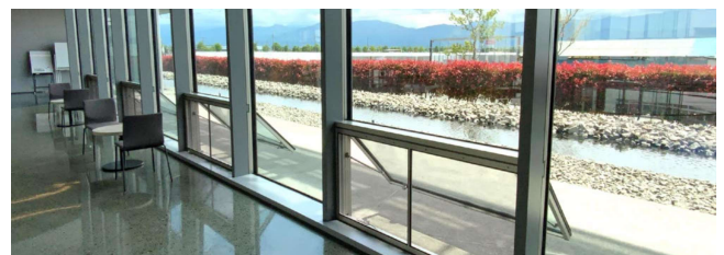
気化冷却効果を狙った水景設備と換気窓
