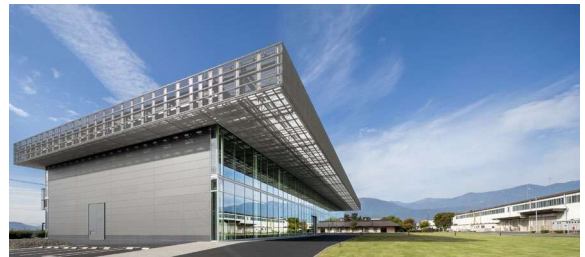
葡萄棚を体現する大屋根・庇
