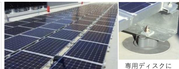
専用ディスクによる架台レス化
