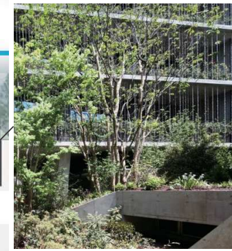
⑤ 地熱利用外気供給システム
