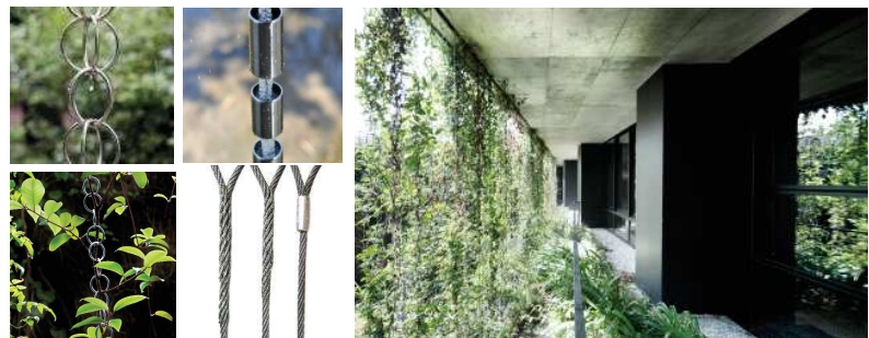
つる植物を伝わせるワイヤーとチェーン 葉面灌水装置を兼ね、蒸散冷却を行う
