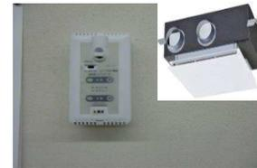
写真-4 導入後のCO2センサーと既存全熱交換器
