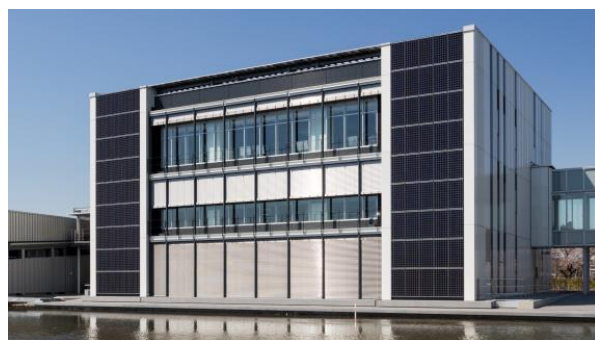
写真-3 南面外観 外ブラインド閉状態
