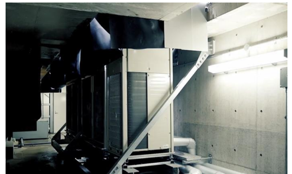
写真-5 空調室外機設置状況
