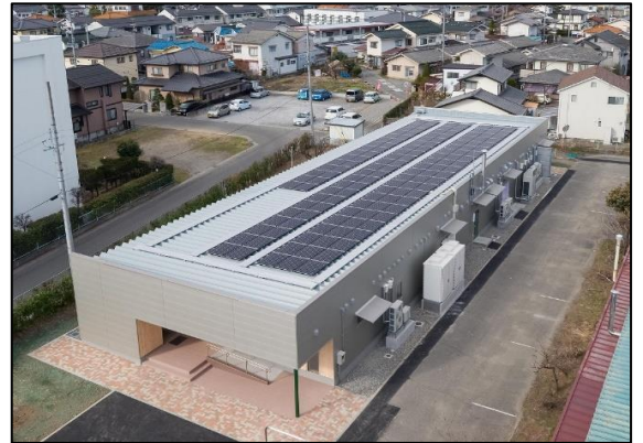
太陽光パネル設置状況
