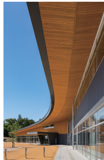
大きく張り出した大屋根 (日射遮蔽)
