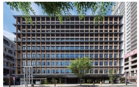
写真2 建物外観（東面）
