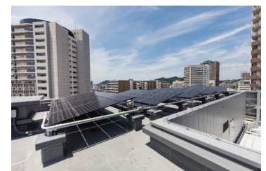
写真3 屋上太陽光発電パネル
