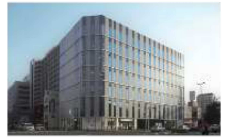
写真-1 外観写真
