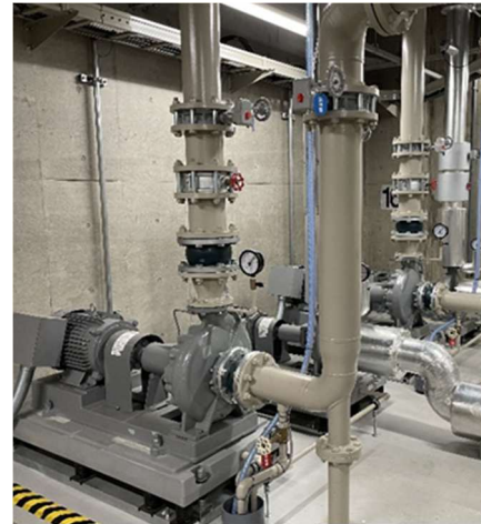
写真 3.3.4.2 ダウンサイジングした貫流ボイラー，冷却塔，熱源ポンプの設置状況
