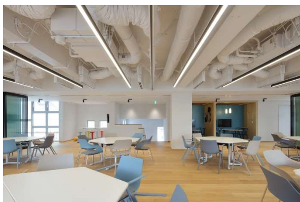
写真 3.4.4.1 あらわし天井の様子（左：2 階ミーティングルーム、右：2 階パントリー）
