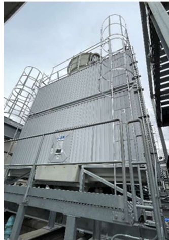
写真 3.3.4.2 ダウンサイジングした貫流ボイラー，冷却塔，熱源ポンプの設置状況
