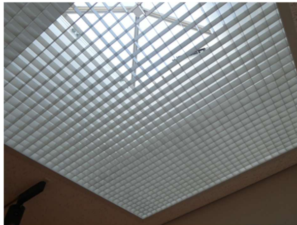
写真 3.4.4.4 既存トップライトによる自然採光 (トイレ)
