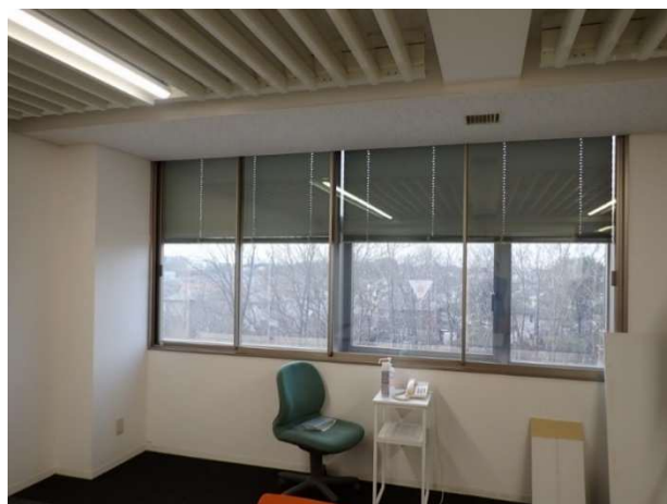
写真 3.5.4.2 既存窓＋後付けサッシ＋太陽光追尾自動ブラインド
