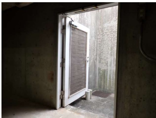
写真 3.5.4.4 免震ピット出入口（ガラリに変更）
