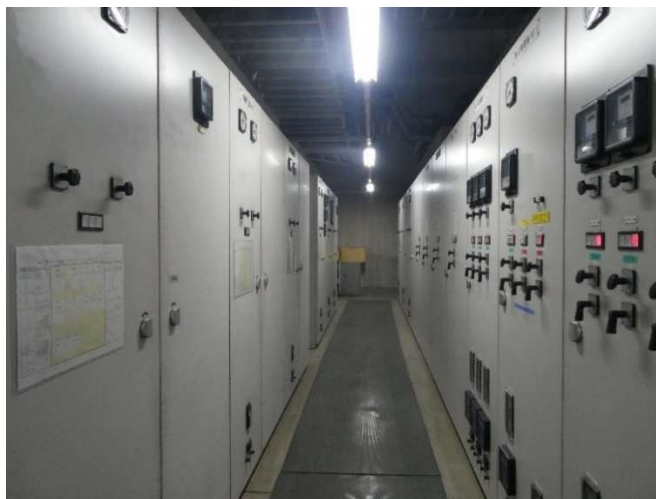
写真 3.3.4.5 高効率変圧器に改修した受変電設備の設置状況
