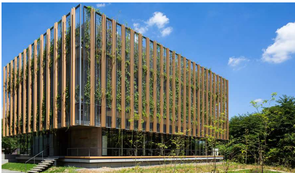
写真 3.6.2.1 グリーンオフィス棟全景（出典：戸田建設㈱HP より）
