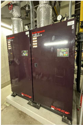
写真 3.3.4.2 ダウンサイジングした貫流ボイラー，冷却塔，熱源ポンプの設置状況
