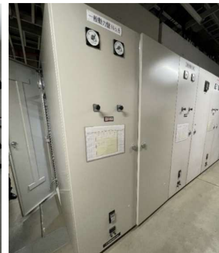
写真 3.3.4.5 高効率変圧器に改修した受変電設備の設置状況
