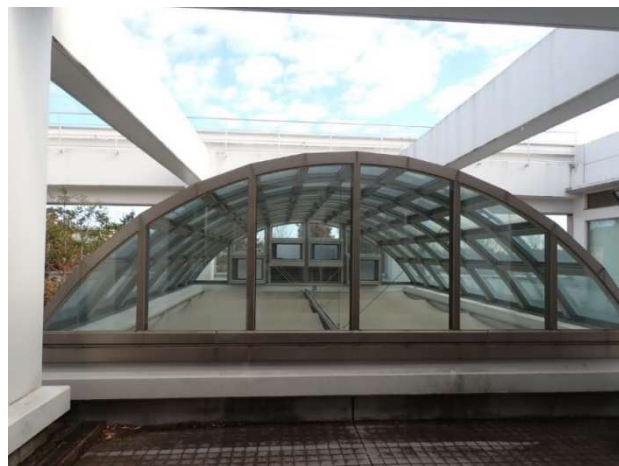
写真 3.5.4.5 エントランスホール上部（排気窓）
