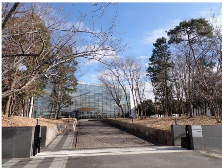
写真 3.5.2.1 つくばテクノセンター全景、本館外観
