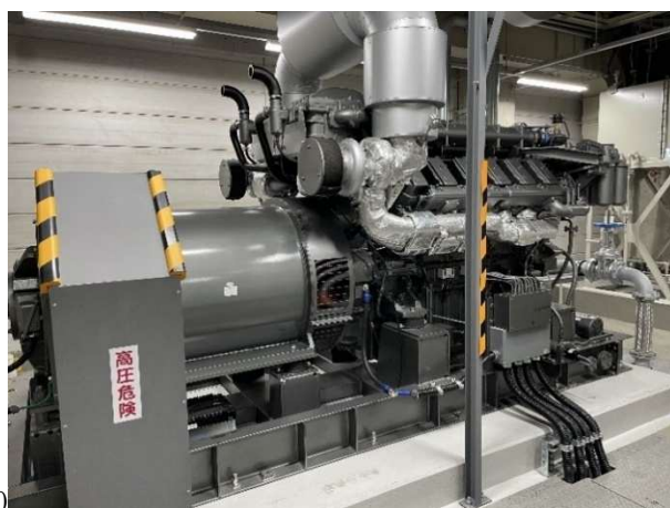
写真 3.3.4.8 更新した非常用発電機の設置状況
