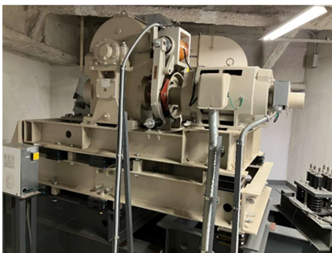
写真 3.3.4.6 高効率モーターに改修したエレベーターの設置状況
