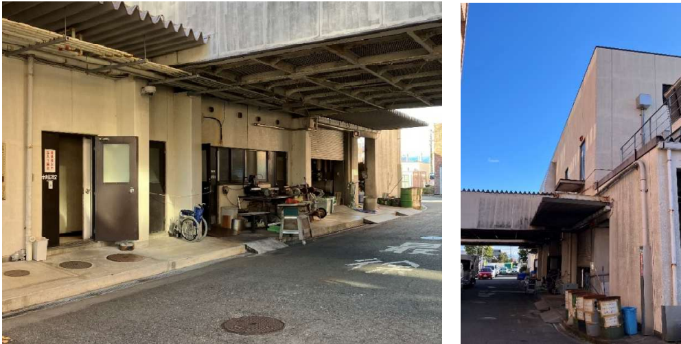
写真 3.1.4.1 エネルギー棟外壁部
